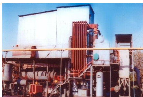
Рисунок 2 Общий вид пилотной установки
